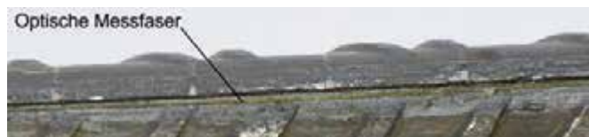
Bild 10 Applizierte optische Messfaser am Betonstabstahl Applied optical measuring fiber on reinforcement bar
