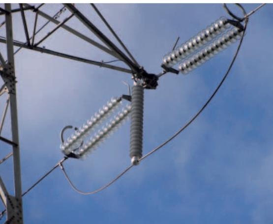
**Bild 3: Faseroptischer Temperatursensor an einer Hochspannungsleitung**
