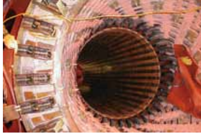
Integration von Temperatursensoren beim Bau eines Generators
