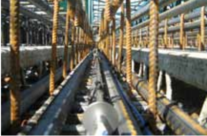
Faseroptischer Dehnungssensor vor dem Beton-Verguss in einem Brückenelement
